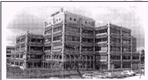
Figuur 3 Gevelbekleding kleur geanodiseerd
