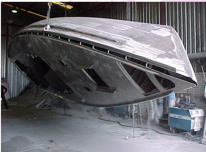
figuur 3: zeiljacht 12 meter, casco gebouwd door Mekon Shipyard
